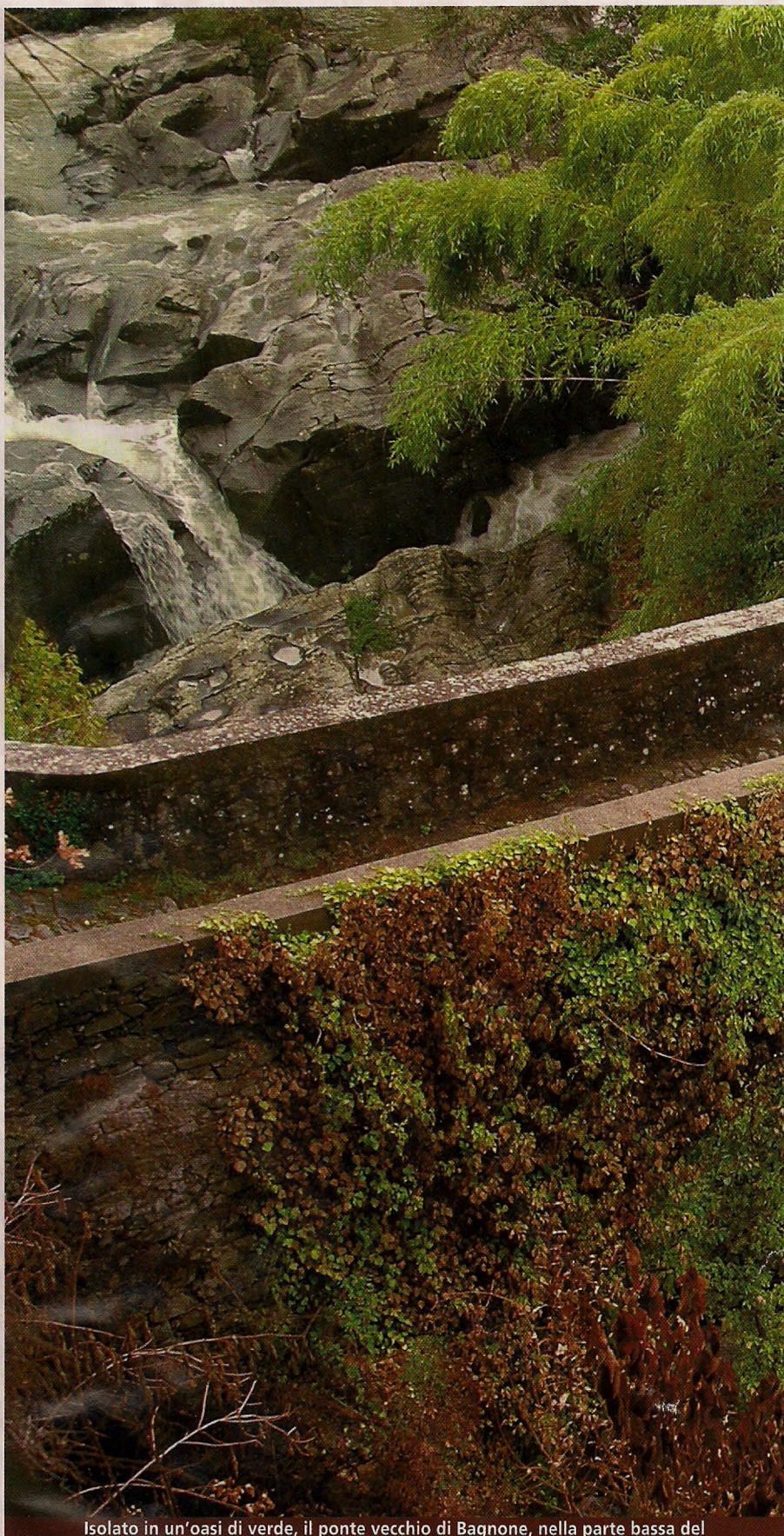
Isolato in un'oasi di verde, il ponte vecchio di Bagnone, nella parte bassa del
